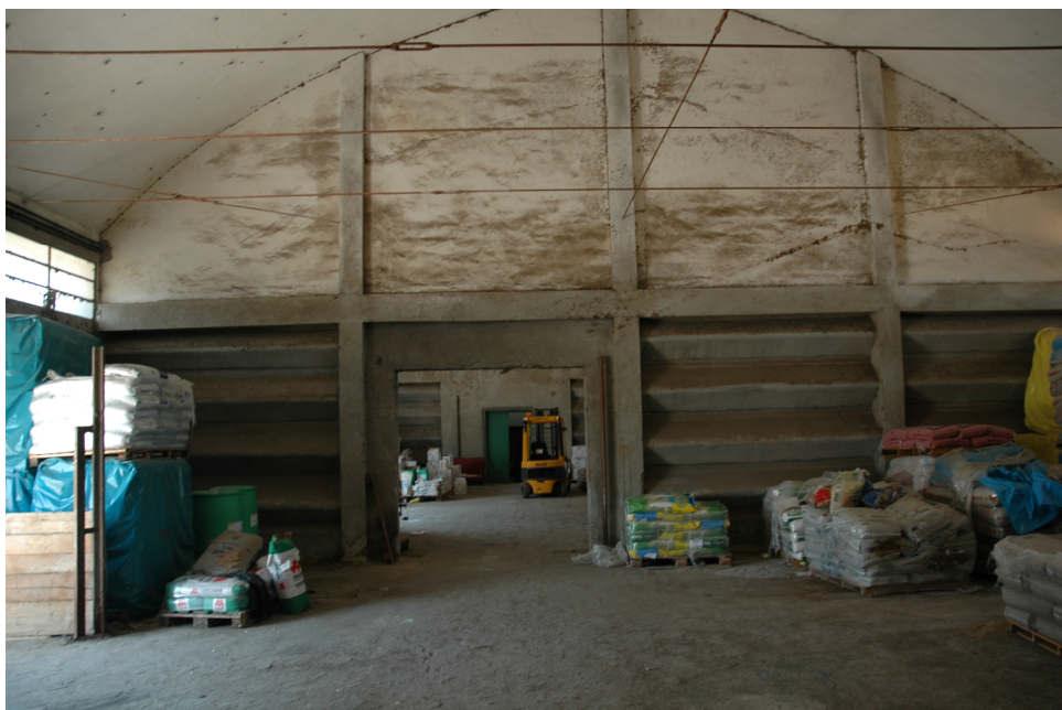
Foto n.5: 4 Cerignola Borgo Tressanti veduta interna magazzino
