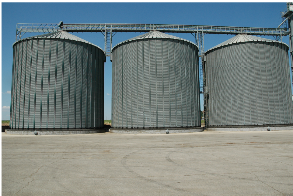
Foto n.2: 2 Lesina complesso silos di Ripalta n.3 silos e piazzale antistante
