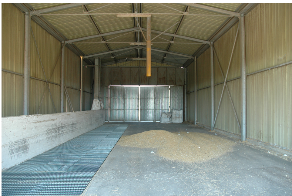
Foto n.4: 2 Lesina complesso silos di Ripalta interno stazione di ricevimento e tramoggia
