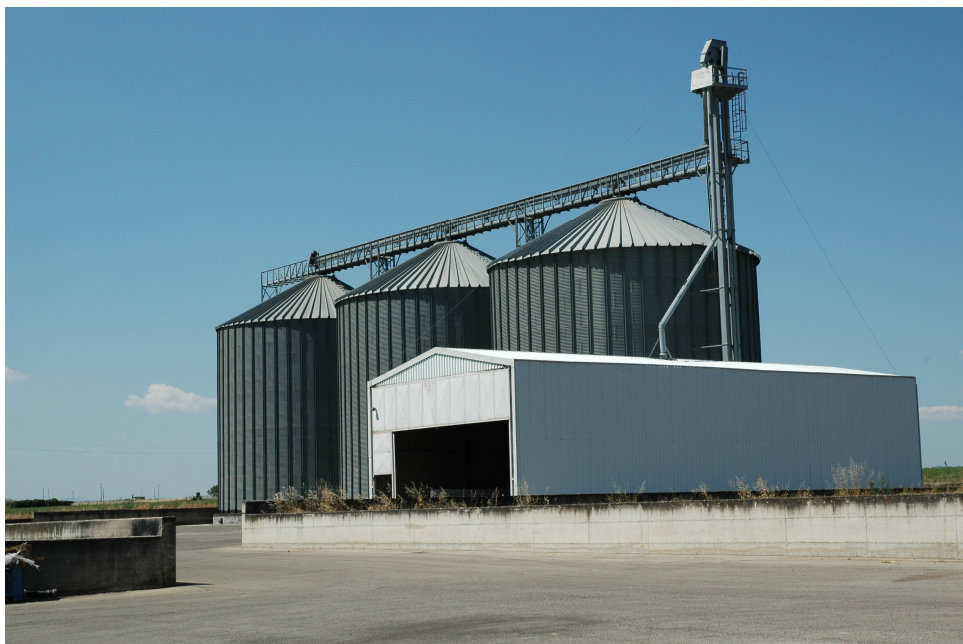
Foto n.1: 2 Lesina complesso silos di Ripalta
