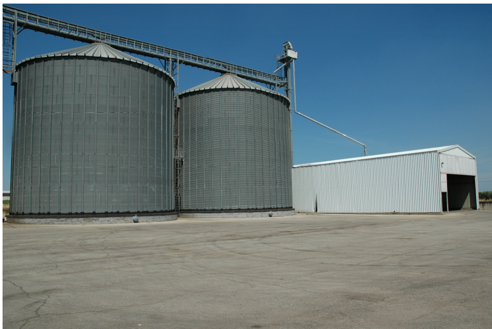
Foto n.3: 2 Lesina complesso silos di Ripalta stazione di ricevimento
